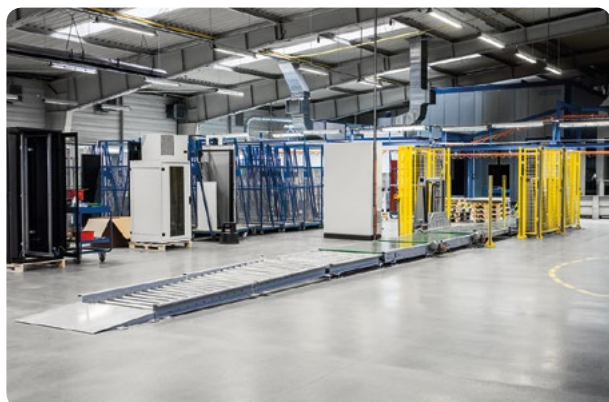
montážní linka stojanových rozvaděčů
