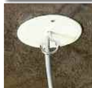
Krabice KBT... zakrytá víčkem V 68 S s vyvedeným vodičem a lustrákem KBP...
