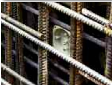
Víčko KBV připevněné na bedněni.
