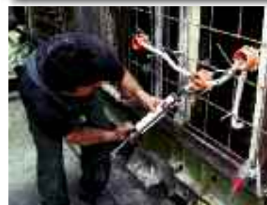
Utěsnění vstupů (tmel).
