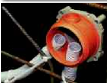
Namontované ohebné trubky do tělesa KBT.
