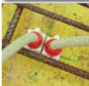
Příklad použití vývodky a koncovky.
