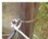
2. Po utáhnutí pás přehnout přes sponu
