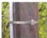
4. Kladivkem pás doložit přes sponu a oříznout přes sponu
