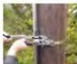
1. Pás nasadí do kleští a ráčnou utáhnout
