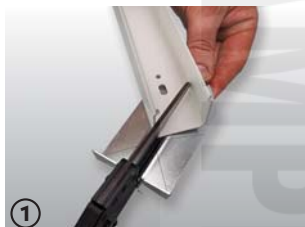
1 vyznačení úhlu 45° střížením podle rýsky na opěrné ploše nůžek
