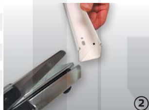
2 45°-vým stříhem vznikne pomyslný bod určující místo dostřížení stěny lišty (viz bod 3)
