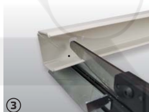
3 nastřížení boční stěny lišty
