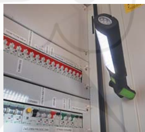
ukázka ukotvení LED lampy pomocí magnetů
