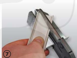
7 ustřížení úhlu 45° krytu lišty střížením podle rýsky na opěrné ploše nůžek
