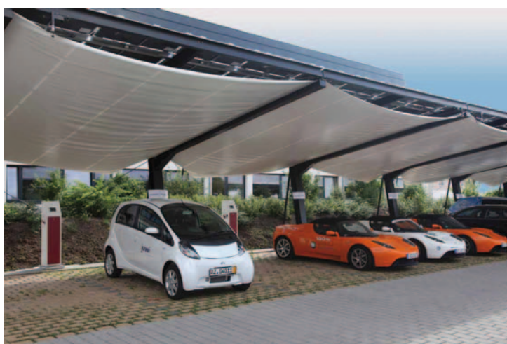
Solární kryté stání jednoho podniku z oblasti obnovitelných zdrojů ECOLECTRA 320 SCHUKO, CEE 32A RFID, tlačítka Stanoviště: Solární kryté stání Wörrstadt
