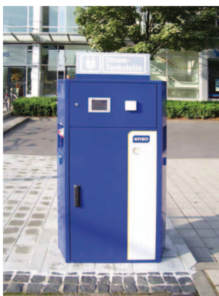
Dodavatel energie AMPEREA 800 SCHUKO, CEE 32A, 7pólový typ 2 RFID, Ethernet, rádiem řízené nabíjení Stanoviště Smart Metering: Drážďany a Großenhain
