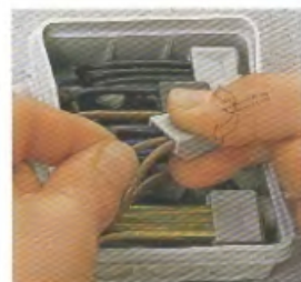
Demontáž: tahem vodiče a současným otáčením svorky sem a tam vodič odpojme
