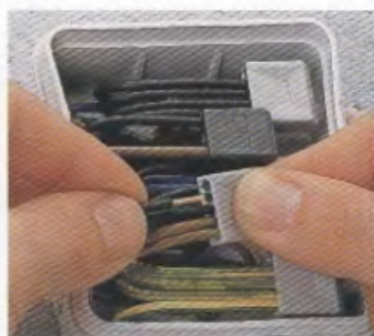
1974 Krabicové svorky pro instalační krabice. Plně izolované svorky s oddělenými spojovacími body až pro osm vodičů umožňují rychlé propojení
