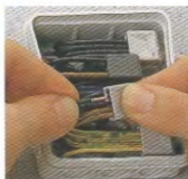
Připojení: odizolovaný vodič nasuneme do svorky
