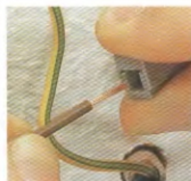
Připojení svítidla: svorku stlačíme a do čtvercového otvoru připojíme laněný vodič
