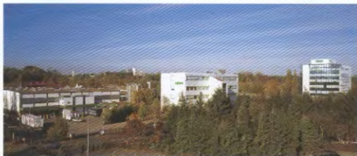
Ústředí firmy WAGO a výrobní závod v Mindenu, Německo
