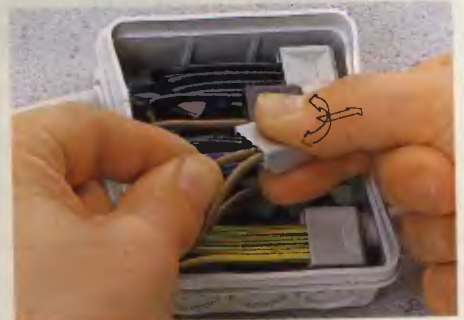
Lösen: Leiter festhalten, Klemme durch Hin- und Herdrehen vom Leiter ziehen
