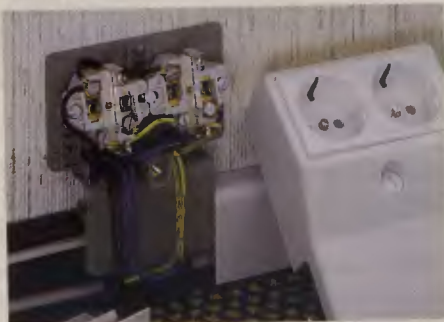
Verbindungs Dosenklemmen im Anschlußraum einer Kabelkanal-Doppelsteckdose
