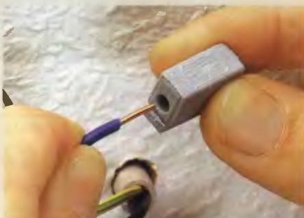
Leiter anschließen: Abisolierten massiven Leiter bis zum Anschlag in die runde Öffnung hineinstecken
