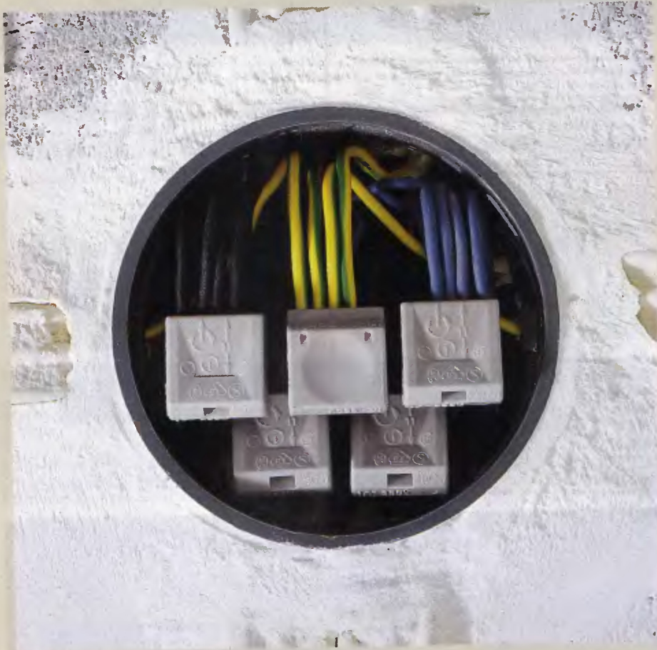
Lösen: Leiter festhalten, Klemme durch Hin- und Herdrehen vom Leiter ziehen
