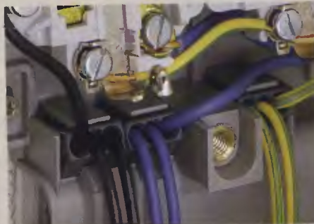
Verbindungs Dosenklemmen im Anschlußraum einer Kabelkanal-Doppelsteckdose
