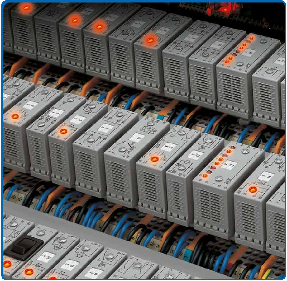
U čtyřvodičových základních svorkových bloků – dvě svěrací místa na každé straně svorky, pro snadné propojení vedení nebo jako rezerva.
