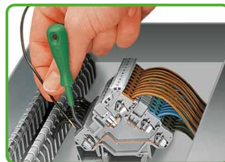
Výše nabízené ovládací nástroje se díky rozměrům svých břitů dle DIN 5264 hodí obzvláště k ovládní svorek pro čidla a akční členy s čelním zapojením řady 280.
