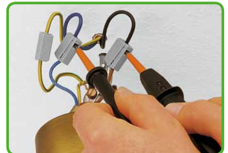
Zkoušení ve zkušebních otvorech
