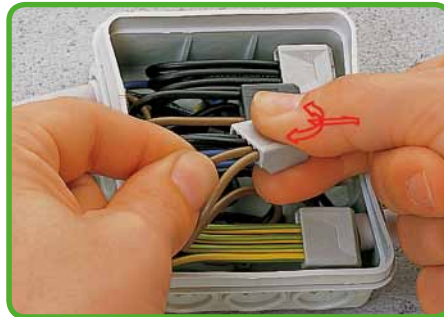
Uvolnění: přidržte vodič, svorku lehkým pootáčením stáhněte z vodiče
