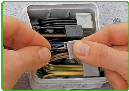
Připojení: Zasuňte plný odizolovaný vodič až na doraz.
