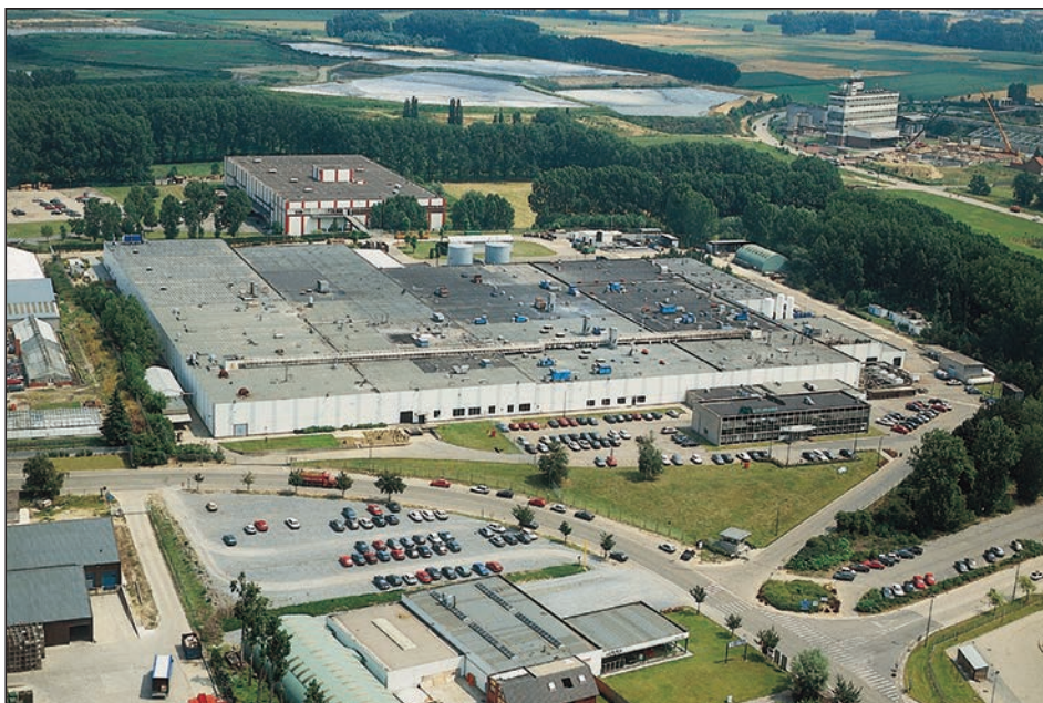
Tienen Factory, Belgium
