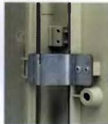
Kovové úchyty na dveřích bránící jejich vypáčení
