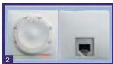
2 • Elektronický termostat, 4 kontaktní telefonní zásuvky RJ45
