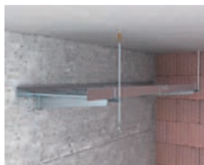
Pomocný závěs s kotvou FZEA Upevnění závitové tyče pomocného závěsu do stropu pomocí kotvy s vnitřním závitem FZEA...
