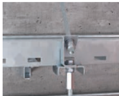
Šikmé připojení pomocného závěsu Detail upevnění šikmého pomocného závěsu pomocí šikmého přípojovacího dílu ABS FS.
