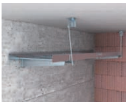
Pomocný závěs se třmenem BSB Zavěšení závitové tyče pomocného závěsu do protipožárního třmenu BSB.
