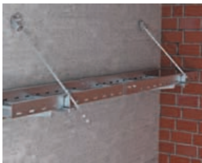
Montáž šikmého závěsu Instalace závitové tyče pomocného závěsu při šikmém vyvěšení ze stěny.
