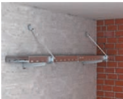
Šikmé nástěnné zavěšení Normový systém se žebříkem LG 60VS/F, výložníky MWA12 a šikmým pomocným závěsem.
