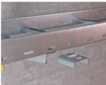
Upevnění pomocného závěsu Nasunutí přípojovacího dílu ABL, zajišťujícího fixaci pomocného závěsu ke kabelovému žebříku.
