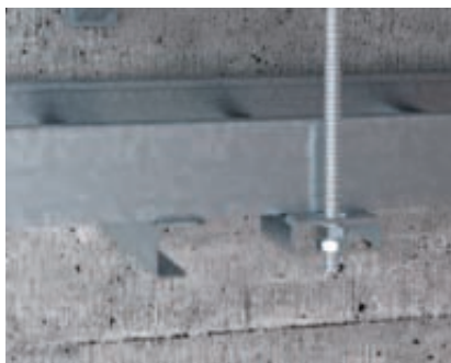
Zajištění závitové tyče Zajištění závitové tyče pomocného závěsu v přípojovacím dílu ABL.
