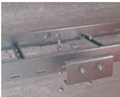
Montáž spojek Montáž vnějších podélných spojek na bočnice kabelového žebříku.
