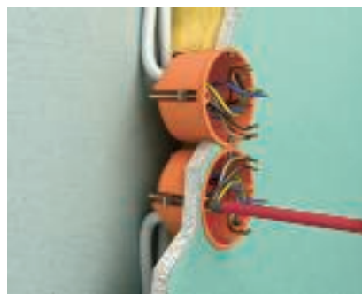
Upevnění krabice do dutých stěn Pomocí šroubováku a upevňovacího šroubu upevněte přístrojové krabice do vyvrtaných otvorů. Potřebnou fixaci zaručují přídržné destičky na zadní straně krabice.
