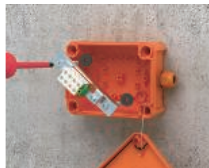
Montáž přípojné jednotky Šroubovací kotvu s těsněním upevněte přes třmen a dno odbočné krabice přímo do podkladu.
