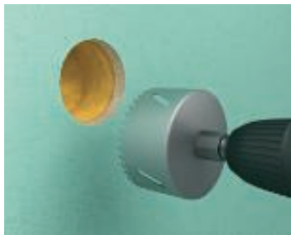
Příprava montážního otvoru Vyznačte si střed otvoru a děrovkou vyřízněte otvor o průměru 68 mm. Při kombinované montáži dodržujte normalizovanou vzdálenost otvorů 71 mm a druhý otvor vytvořte svisle nebo vodorovně vůči prvnímu.
