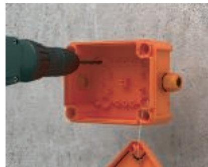
Zhotovení upevňovacích otvorů Vývrtání otvorů ve dně pro upevnění na stěnu.
