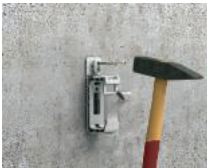
Upevnění pomocí natloukací hmoždinky Natloukací hmoždinku zasuňte společně s upevňovacím prvkem do vyvrtaného otvoru a zatlučte ji kladivem.
