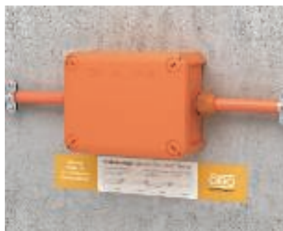
Označení Nalepte štítek s údaji o kabelovém zařízení dle normy DIN 4102, část 12.
