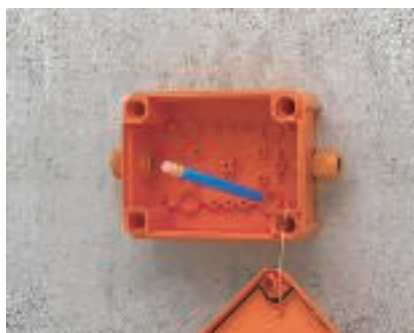
Příprava montáže Označení otvorů k vyvrtání za účelem následné montáže.
