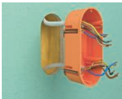
Montáž dvojitého přístrojového krabice Vedení a/nebo trubky se nejprve zavedou do přístrojové krabice, v níž se automaticky upevní. Poté přístrojové krabice vložte do vrátaného otvoru.
