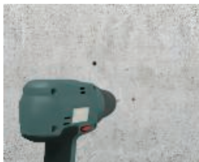
Vyvrtání upevňovacích otvorů Průměr vyvrtaného otvoru 5 mm, hloubka 60 mm. Otvory dobře vyčistěte!
