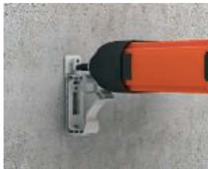
Montáž pomocí pneumatické hřebíkovačky na stěnu Upevňovací prvek svazkového držáku lze nasadit na hlavu pneumatické hřebíkovačky; upevnění je díky speciálním lamelám automatické. Upevnění se provádí bez dalších pomůcek přímo pneumatickou hřebíkovačkou na stěnu nebo strop.
