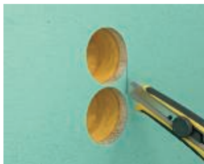
Příprava montážního otvoru pro dvojité přístrojové krabice Při použití 2 násobné přístrojové krabice se nejprve vyvrtají dva otvory ve vzdálenosti 71 mm s průměrem 68 mm. Zbytek se vyřízne nožem.
