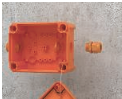
Montáž kabelových vývodů Upevnění kabelových vývodů V-TEC pomocí pojistných matic.
