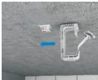
Upevnění svazkového držáku Nasadte držák Grip na dříve oddělený upevňovací prvek.
