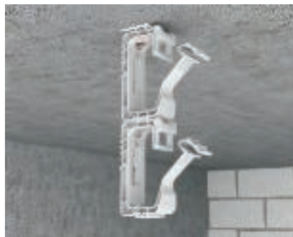
Řazení pod sebe Více svazkových držáků lze řadit pod sebe. V závislosti na zatížení a upevnění byste neměli sdružovat více než dva svazkové držáky OBO.
