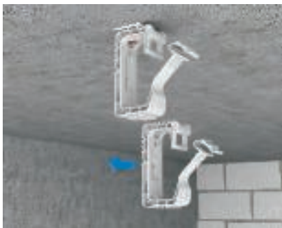
Řazení pod sebe Díky patentovanému řadicímu systému lze svazkové držáky OBO vzájemně spojit.
