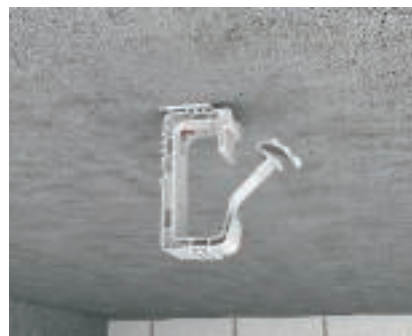
Hotová montáž svazkového držáku Jakmile dosáhnete správné polohy, držák Grip se citelně zaklapne.
