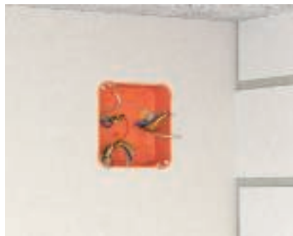
Instalace hranaté propojovací krabice S hranatými propojovacími krabicemi do dutých stěn lze vytvořit rozvody ve stěně.
