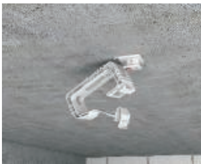
Upevnění svazkového držáku Tahem a otočením oddělte upevňovací prvek od držáku Grip.
