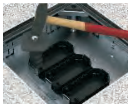
Montáž přístrojů pod kazetu Vložte montážní sadu do podlahové krabice a upevněte ji k podlaze.
