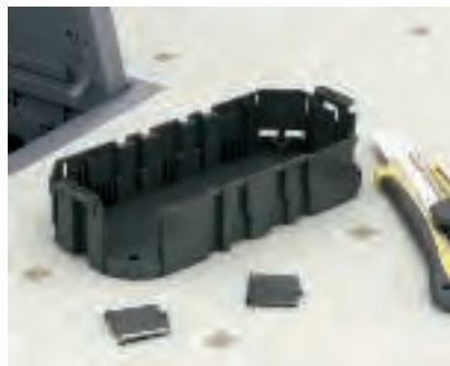
Příprava přístrojové vložky Za účelem zavedení vodičů otevřete boční stěnu přístrojové vložky.
