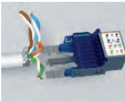
Připojení přístroje – příprava kabelů Odstraňte vnější plášť kabelu datové techniky a případně i stínění v délce 50 mm.
