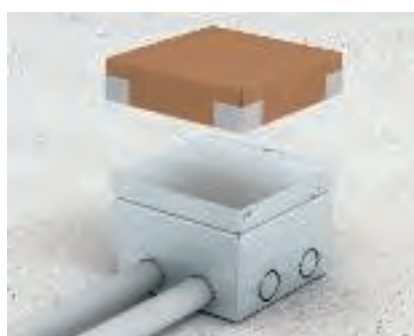
Nasazení ochranného montážního víka Přiložte ochranné montážní víko z ocelového plechu a zakryjte je připraveným kartonovým krytem.
