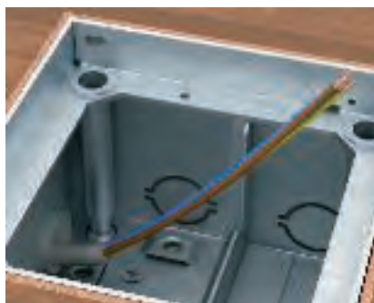
Příprava připojovacího vedení pro zásuvku Připravte připojovací vedení pro zásuvku.
