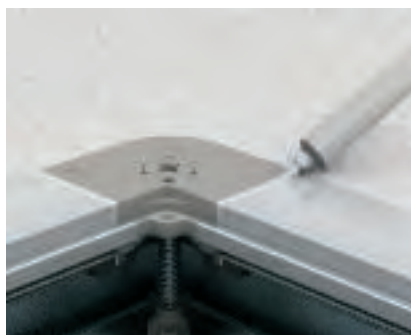
Utěsnění podlahové krabice silikonem Rám podlahové krabice utěsněte v prostoru rohů silikonem (silikon je součástí dodávky kazety).
