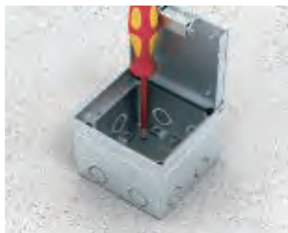
Montáž na nosný strop Vestavnou jednotku upevněte na nosný strop.
