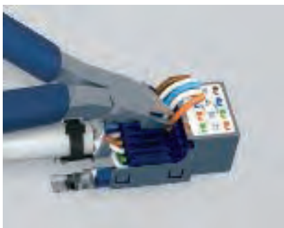
Připojení přístroje – zkrácení nadměrné délky Přebytečný kabel odstříhnete štipacími kleštěmi.
