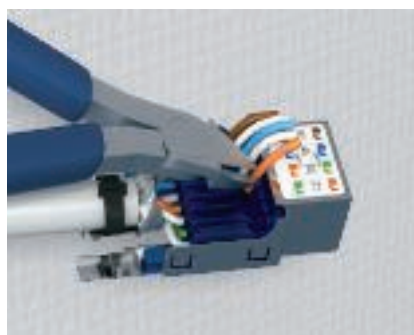
Připojení přístroje – zkrácení nadměrné délky Přebytečný kabel odstříhnete štípacími kleštěmi.
