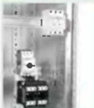
Příklad upevnění různých typů přístrojů pro různou hloubku montáže
