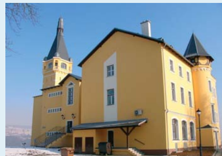
Hotel Větruše, Ústí nad Labem, ČR Svítidla G5
