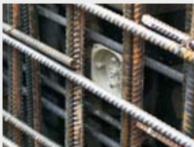
Víčko KBV připevněné na bedněni.
