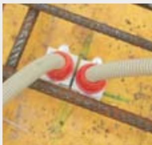
Příklad použití vývodky a koncovky.
