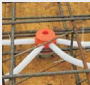
Příklad použití na horizontální bedněni.
