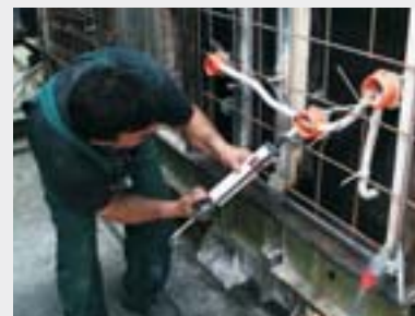
Utěsnění vstupů (tmel).
