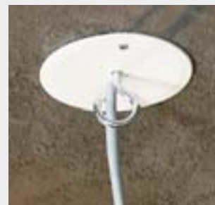
Krabice KBT... zakrytá víčkem V 68 S s vyvedeným vodičem a lustrhákem KBP...
