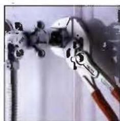
Arbeiten an verchromter Armatur
