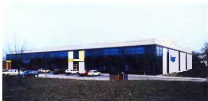
Telford (Anglie) výroba rozvaděčů a rozvodnic
