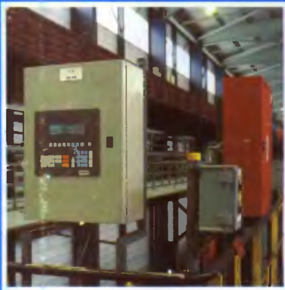
ARIA a APO, polyesterová zapouzdření pro agresivní prostředí.
