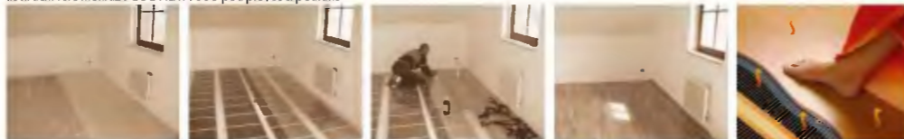
Ilustrační foto montáže ECOFILM F608 pod plovoucí podlahou
