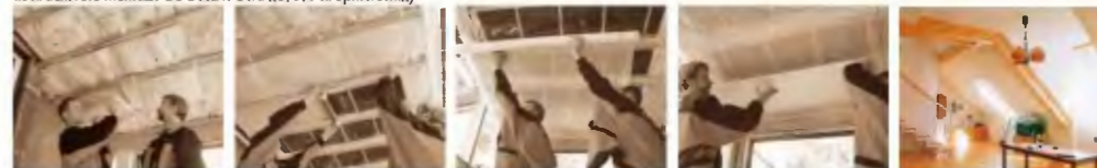
Ilustrační foto montáže ECOFILM C na kovové stropní nosníky
