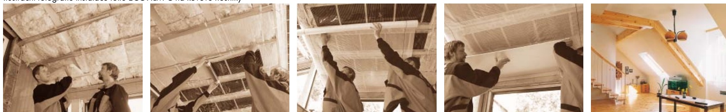
Ilustrační fotografie instalace folie ECOFILM C na kovové nosníky
