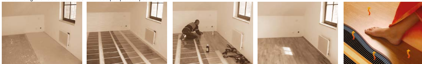
Ilustrační fotografie instalace folie ECOFILM F608 pod plovoucí podlahu
