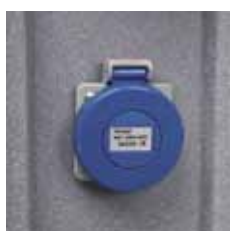
Klasické zásuvky 230V/16A s ochranným kolíkem v krytí IP67
