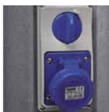
Blokované vestavné zásuvky 230V/16A v krytí IP67
