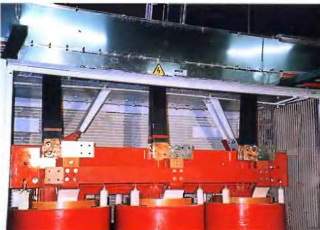
SPOJE MEZI TRANSFORMÁTOREM MTBT A HLAVNÍ NÍZKONAPĚŤOVOU DESKOU
