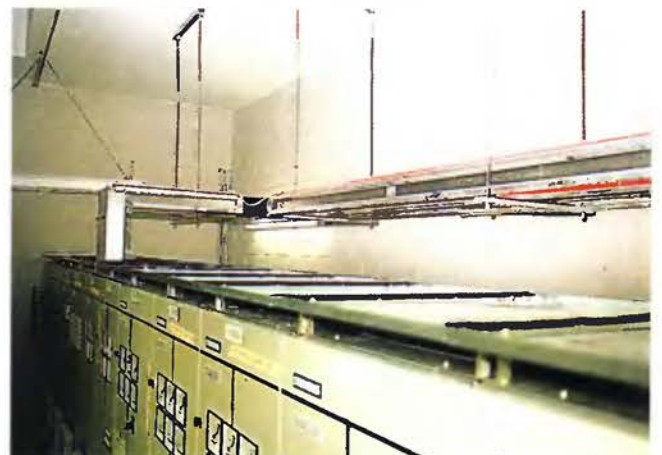
SPOJE MEZI TRANSFORMÁTOREM MTBT A HLAVNÍ NÍZKONAPĚŤOVOU DESKOU
