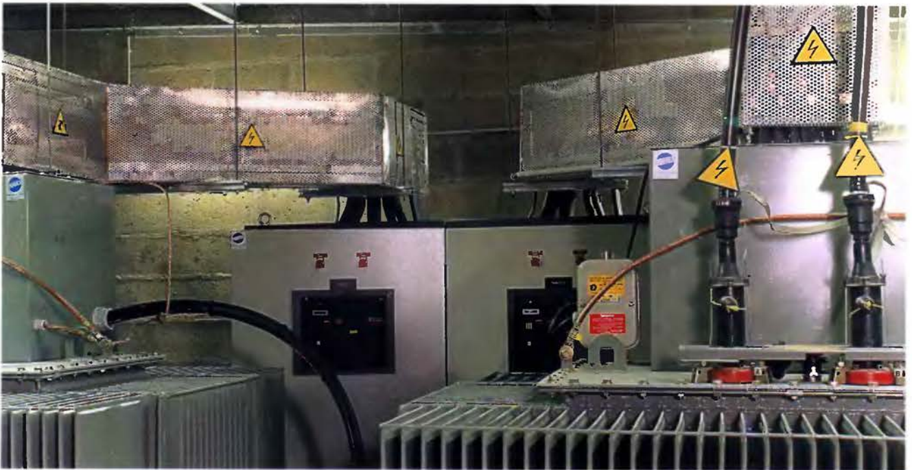
SPOJE MEZI TRANSFORMÁTOREM MTBT A HLAVNÍ NÍZKONAPĚŤOVOU DESKOU
