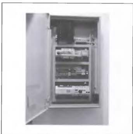
Příklad řídicího systému pro regulaci vodních ohřivačů, dvě větve, regulace otáček hvězda/trojúhelník
