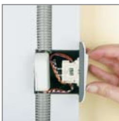
Integrace klasického spínače do RF systému s využitím binárního vstupu
