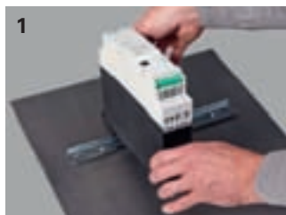
1 Zacvaknout frekvenční startér na montážní lištu.
