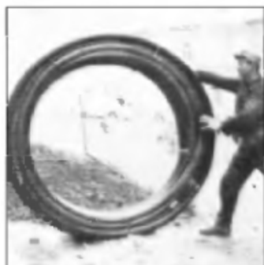
Přeprava kotouče KSX na stavbu
