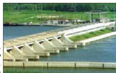
elektrárna, Rakousko elektrárna, Rakúsko
