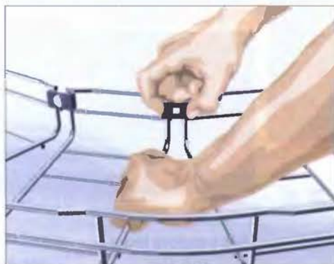
1 - Jedna ruka přidržuje 2 dráty, spojovací součást CE 30 je uvnitř ohybu přidržovaná druhou rukou.
