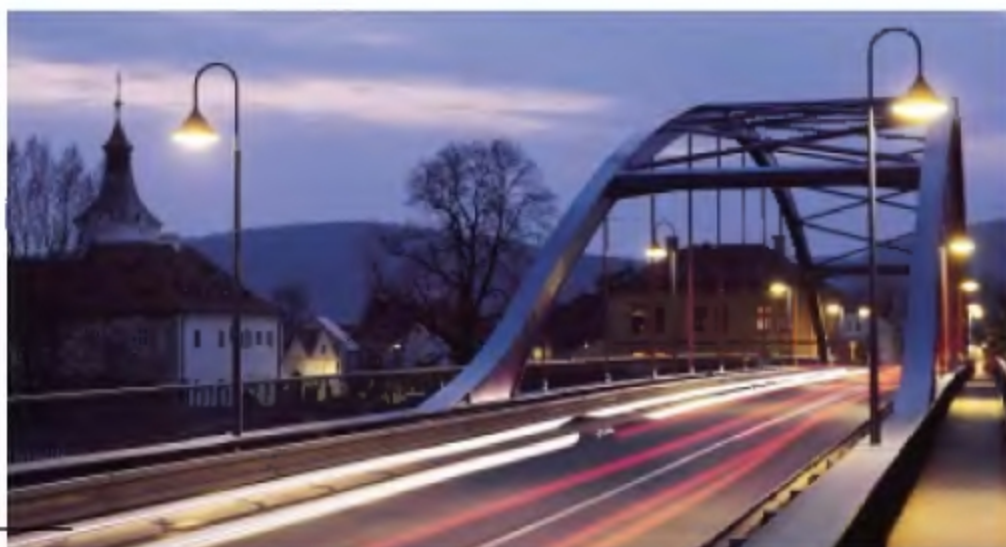
most přes Berounku v Dobřichovicích
