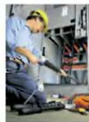
Montáž staniční koncovky
