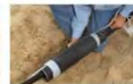
Smrštění vnější ochranné trubice
