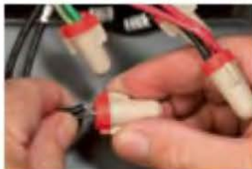
Našroubování konektoru na vodiče
